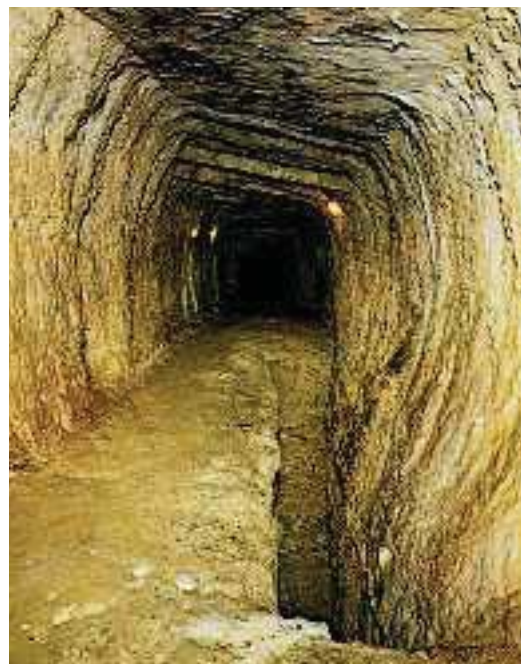
5. Ένα τμήμα της σήραγγας που ανοίχθηκε στο λόφο.
